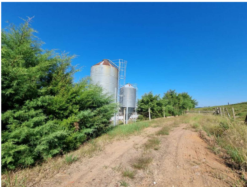
Foto 48: Vista dos silos metálicos dos aviários,
