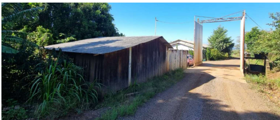
Foto 38: foto dos fundos do galpão garagem/depósito
