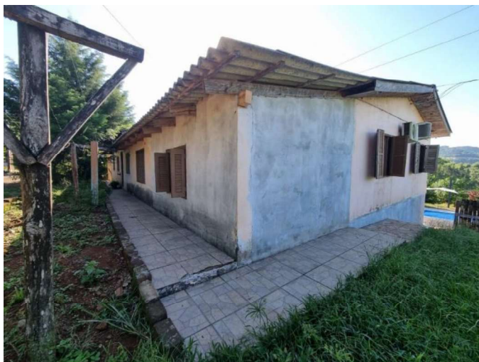
Foto 31: Fachada lateral voltada para a estrada de acesso
