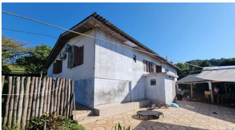
Foto 33: Fachada lateral voltada para a estrada de acesso
