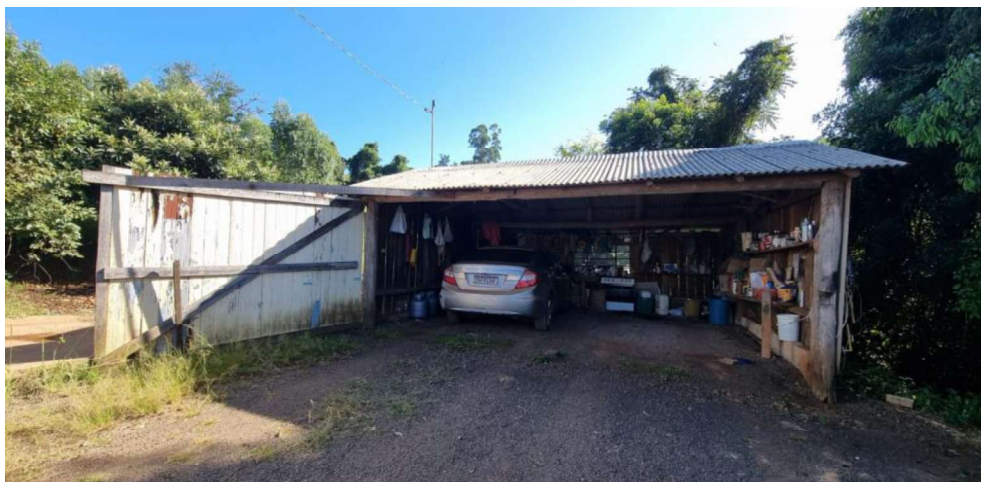
Foto 37: foto frontal do galpão garagem/depósito
