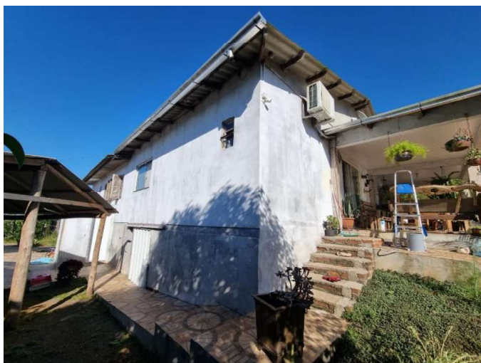
Foto 32: Fachada lateral voltada para a estrada de acesso
