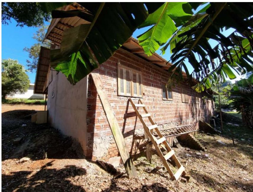
Foto 12: Foto dos fundos da edificação
