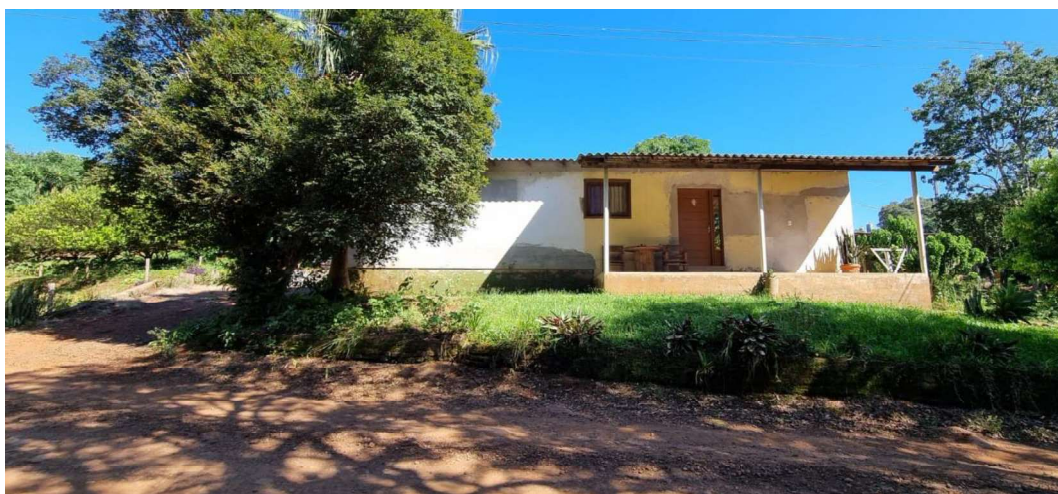
Foto 13: Fachada frontal voltada para a estrada
